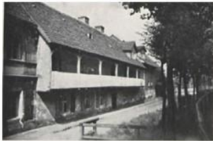
An der Lazarettstraße — ehemalige Torwächterhäuser
