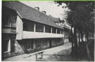
An der Lazarettstraße — ehemalige Torwächterhäuser
